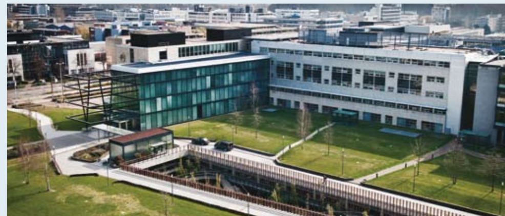
In de Plaspoelpolder werken eigenaren, ondernemers en gemeente samen aan de herontwikkeling van het bedrijventerrein
